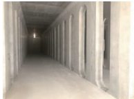
工事中の地下貯留施設(田原本町)
