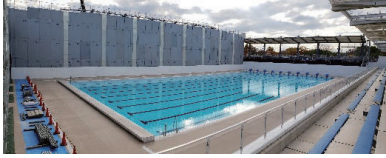
膜屋根及び観客席増設工事 施工状況 (R2.11.19)
