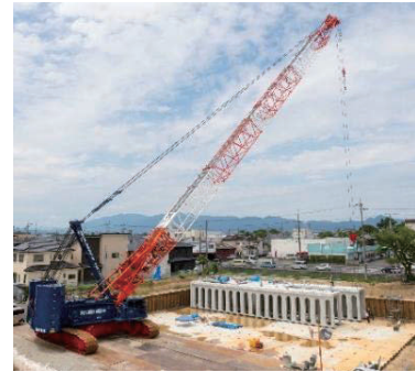
工事中の地下貯留施設(田原本町)
