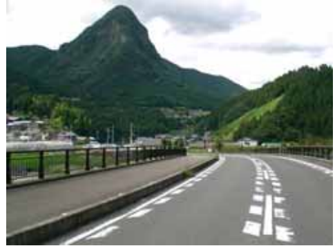
主要地方道名張曾爾線 / 曾爾村 特徴的な形の山を内部景観に取り入れた道路線形を採用。
