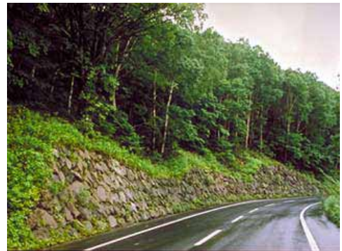
志賀ルート / 長野県下高井郡山ノ内町 志賀高原 道路整備に伴い現場で発生した巨石を空積み することで周辺景観になじんだものとなっている。
