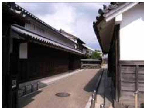
今井町(重要伝統的建造物群保存地区) / 橿原市 街並みに違和感なく溶け込む舗装色としている。
