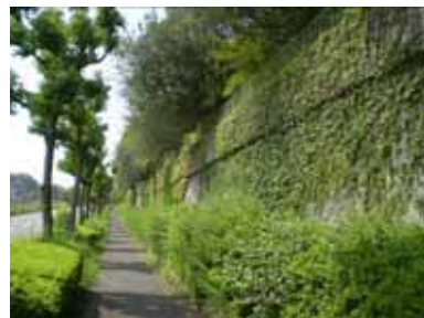
擁壁前面の蔦が生長し、周辺景観になじんでいる。
