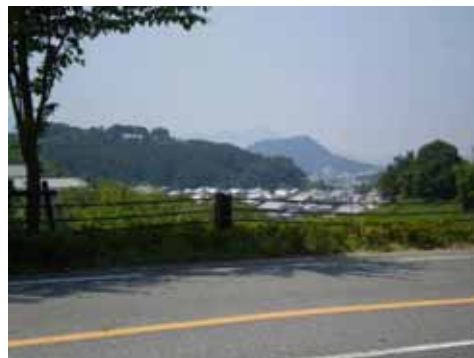
主要地方道桜井明日香吉野線 / 明日香村 防護柵に茶系色のガードケーブルを使用することで、眺望に配慮している。
