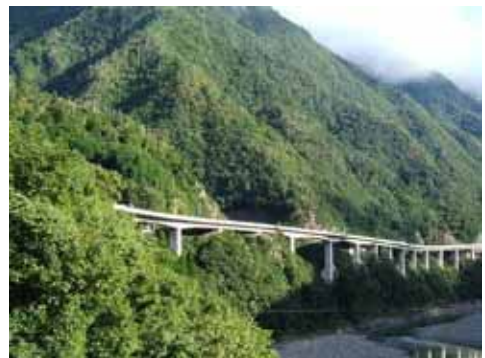
国道 168 号 (七色高架橋) / 十津川村 急峻な斜面が連続する厳しい地形条件下において、環境保全を可能とする構造及び施工法を採用。
