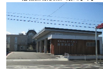
桜井消防署新庁舎
