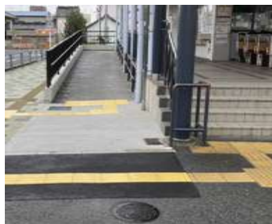
近鉄西田原本駅（田原本町）におけるスロープ改良 <2020（令和2）年度実施>
