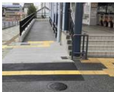
近鉄西田原本駅（田原本町）におけるスロープ改良 〈2020（令和2）年度実施〉
