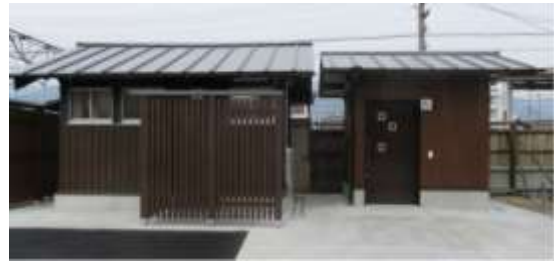
JR御所駅への多機能トイレの設置
