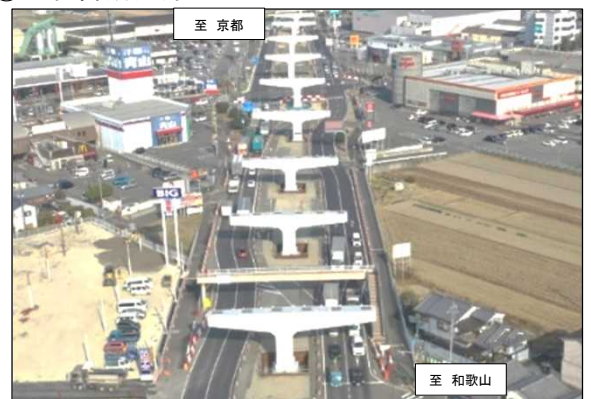
橋梁下部工事(橿原市曲川町)
