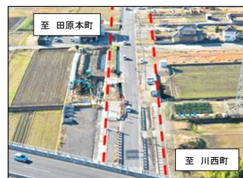
4車線拡幅工事を推進(三宅町伴堂)
