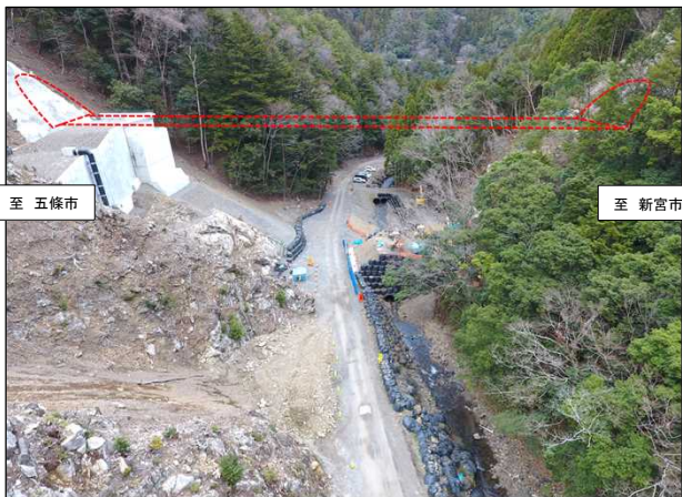
橋梁下部工事を推進(十津川村長殿)
