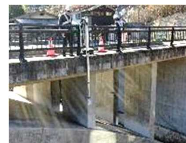
新技術を活用した点検(ロボットカメラの活用)
