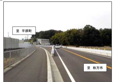
2車線暫定供用区間(生駒市小平尾町)
