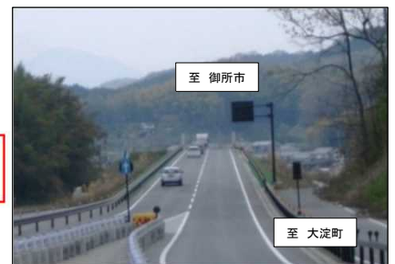
松山高架橋(高取町松山)
