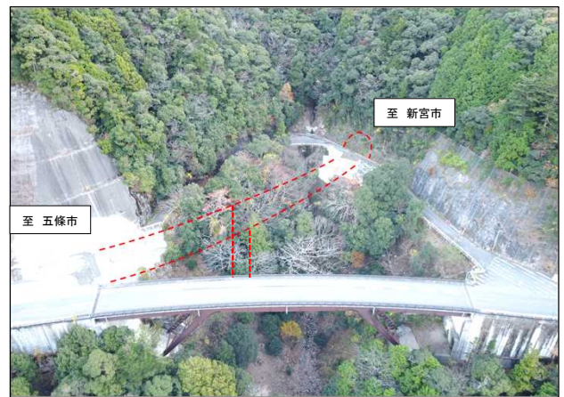
橋梁下部工事を推進(十津川村川津)
