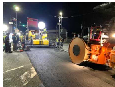
舗装補修工事の状況
