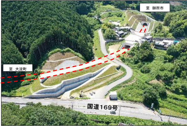
清水谷高架橋工事を推進(高取町清水谷)
