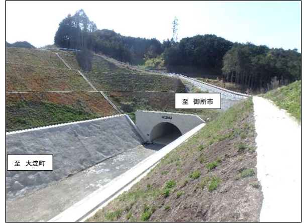
高取トンネル[H31年1月完成](高取町清水谷)
