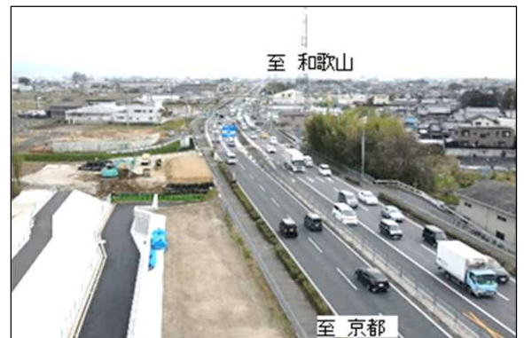
道路拡幅工事(大和郡山市下三橋町)
