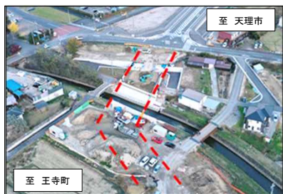
橋梁工事を推進(河合町川合)
