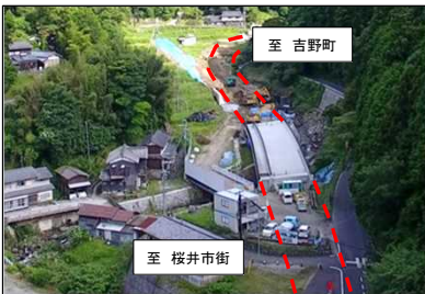
2車線改良工事を推進(桜井市百市)
