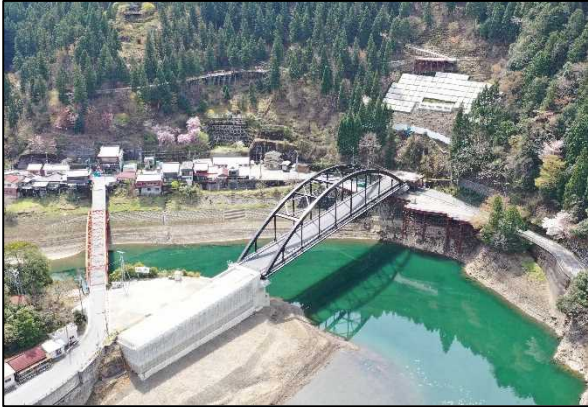
(仮称)新阪本橋[R3年2月完成](五條市大塔町)
