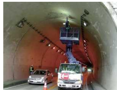
トンネル定期点検の状況
