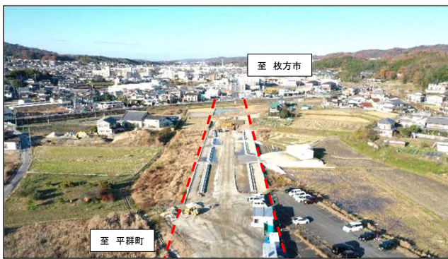
4車線のバイパス工事を推進(生駒市小瀬町)
