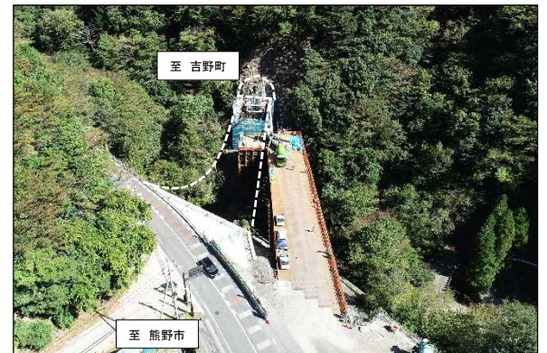
橋梁下部工事を推進(上北山村西原)
