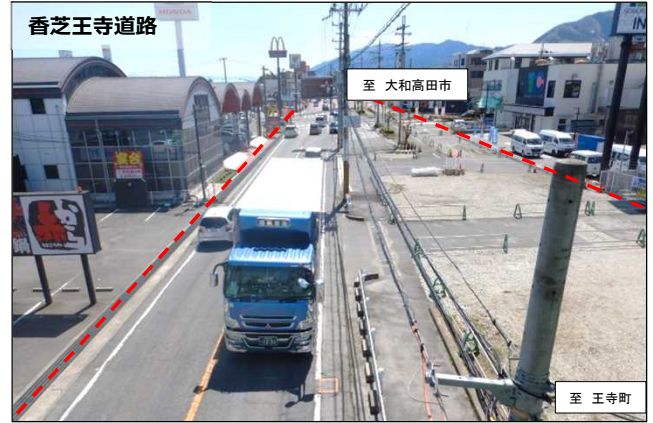
4車線拡幅工事を推進(香芝市上中)
