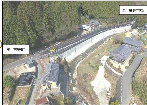
現道拡幅(桜井市百市)
