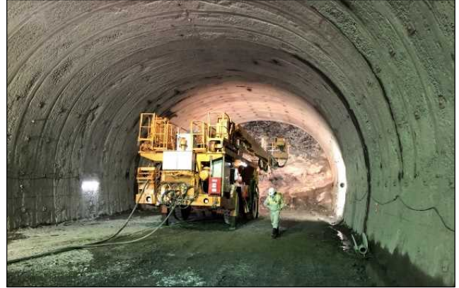
トンネル工事を推進(五條市大塔町)
