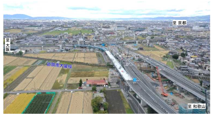
大和御所道路(橿原北IC～橿原高田IC)の工事状況
