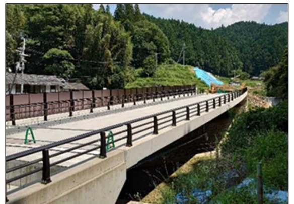
もものいち桜橋[R2年6月完成]
