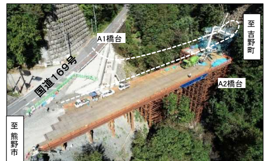
橋梁下部工事を推進(上北山村西原)
