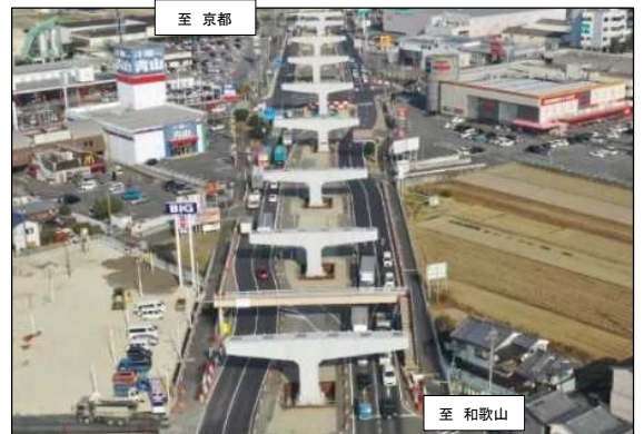
橋梁下部工事(榎原市曲川町)
