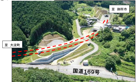
清水谷高架橋工事を推進(高取町清水谷)
