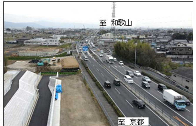
道路拡幅工事(大和郡山市下三橋町)
