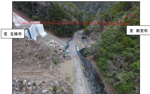
橋梁下部工事を推進(十津川村長殿)
