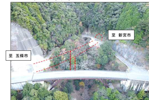
橋梁下部工事を推進(十津川村川津)
