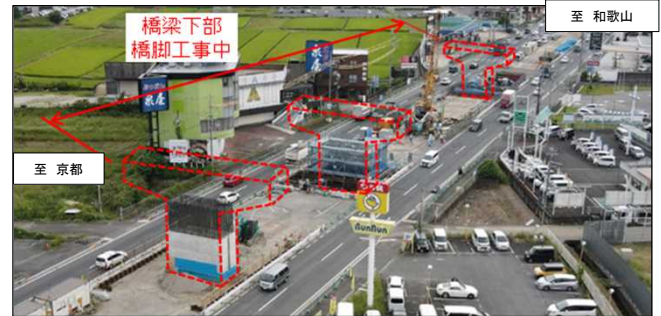
橋梁下部工事等を推進(大和郡山市横田町)
