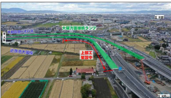
大阪方面接続ランプ工事を推進(榎原市新堂町)
