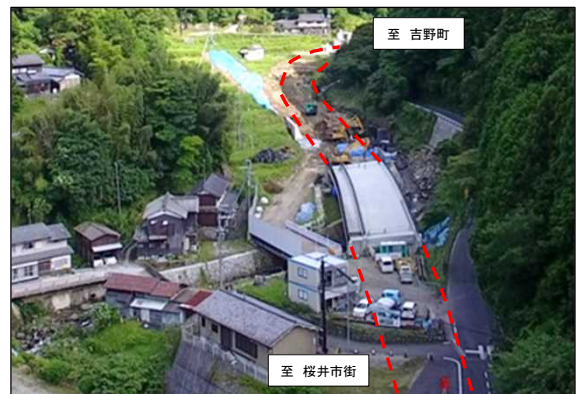
2車線改良工事を推進(桜井市百市)
