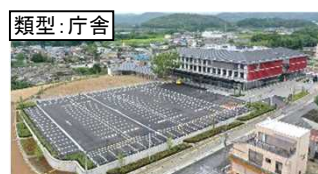
五條市 五條中心市街地地区 (合同庁舎・賑わい空間/R3年7月完成)
