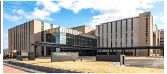
新奈良県総合医療センター
