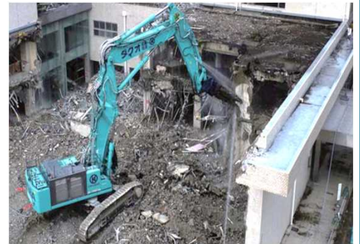
旧奈良県総合医療センター(除却)
