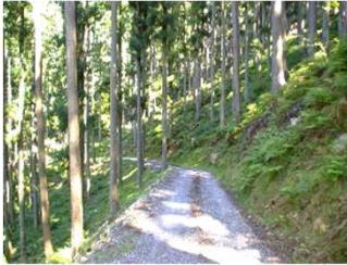
整備された奈良型作業道
