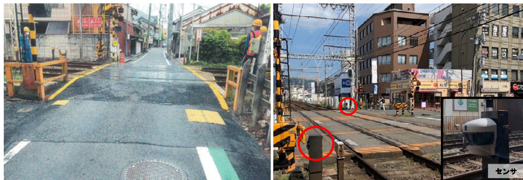
踏切障害物検知装置 (近鉄奈良線新大宮駅付近)
