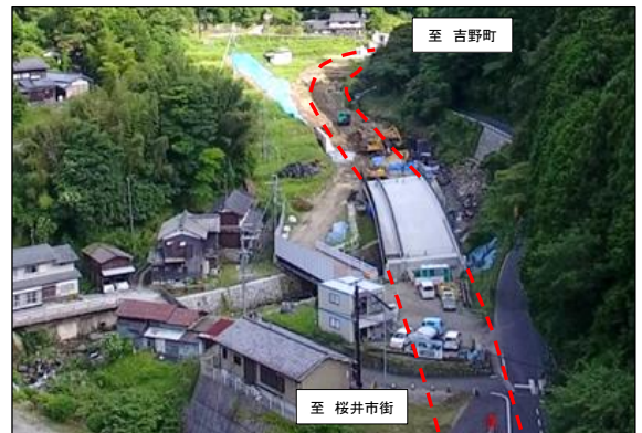
2車線改良工事を推進(桜井市百市)
