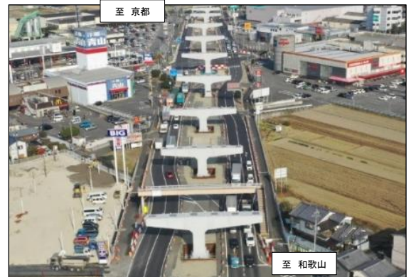
橋梁下部工事(橿原市曲川町)
