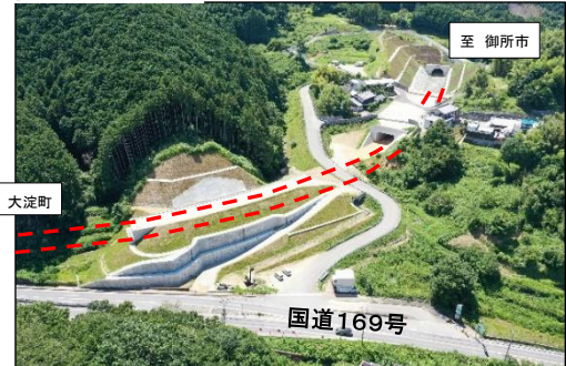
清水谷高架橋工事を推進(高取町清水谷)
