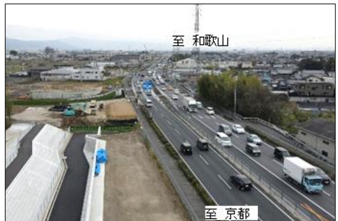
道路拡幅工事(大和郡山市下三橋町)
