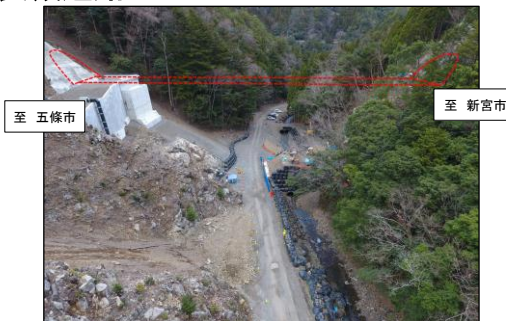
橋梁下部工事を推進(十津川村長殿)
