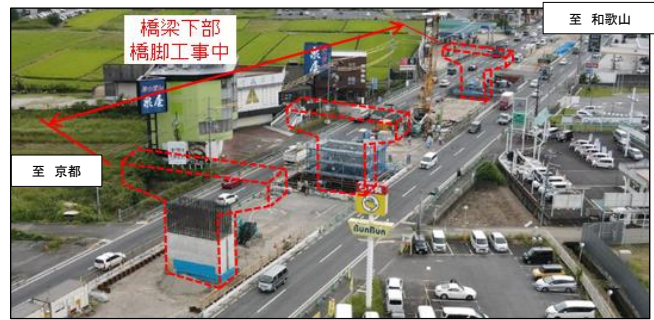
橋梁下部工事等を推進(大和郡山市横田町)
