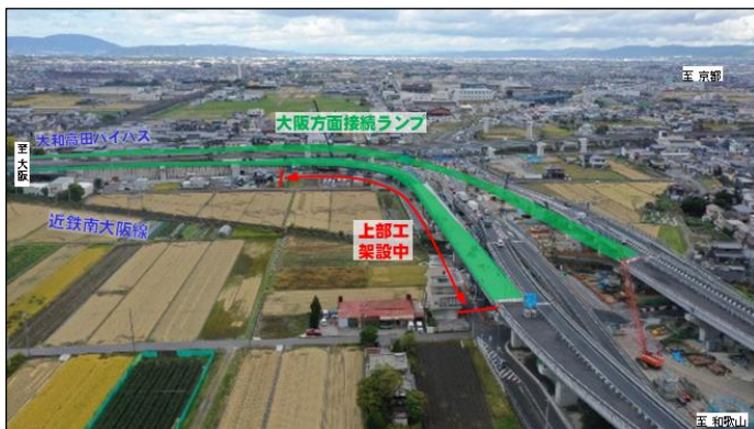
大阪方面接続ランプ工事を推進(橿原市新堂町)
