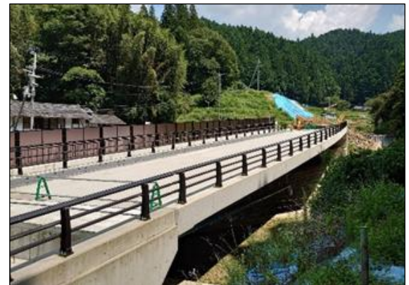
もものいち桜橋[R2年6月完成]
