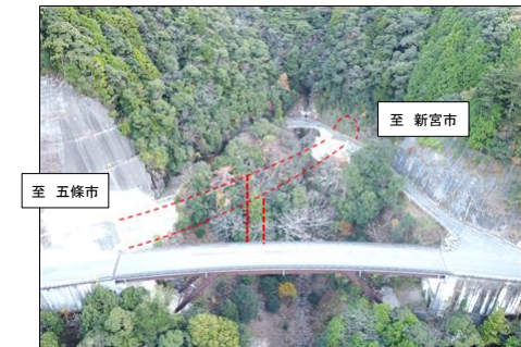
橋梁下部工事を推進(十津川村川津)
