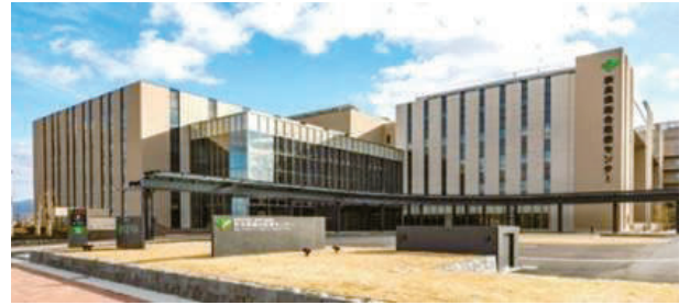
新奈良県総合医療センター
