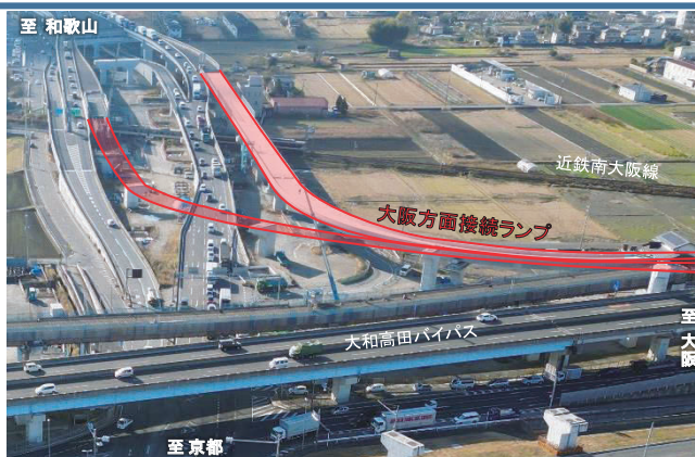
大和御所道路(仮称)榎原JCTランプ工事を推進
