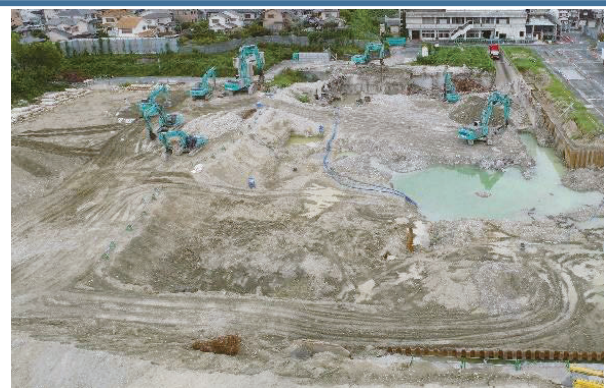
旧奈良県総合医療センター(除却)
