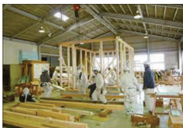
模擬住宅建築実習(高等技術専門校建築科)
