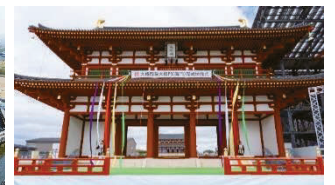
第一次大極殿院大極門(南門)
