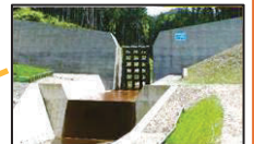
透過型砂防堰堤の設置
