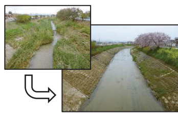
しゅんせつ 河川の浚渫を実施(堆積土砂撤去)
