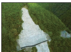
道路斜面の崩壊対策
