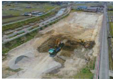
【工事中】流域貯留施設(王寺町)
