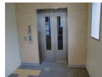
エレベーター設置(坊城駅)
