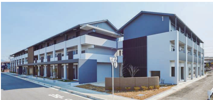
桜井県営住宅第1期
