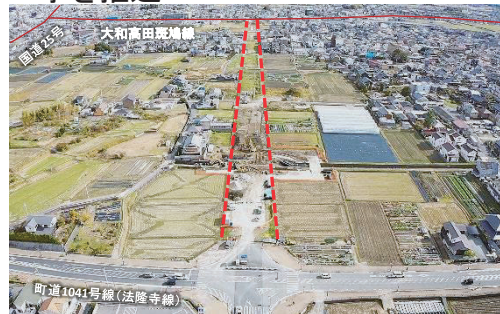
2車線バイパス工事を推進(斑鳩町五百井)
