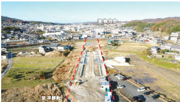
4車線バイパス工事を推進(生駒市小瀬町)
