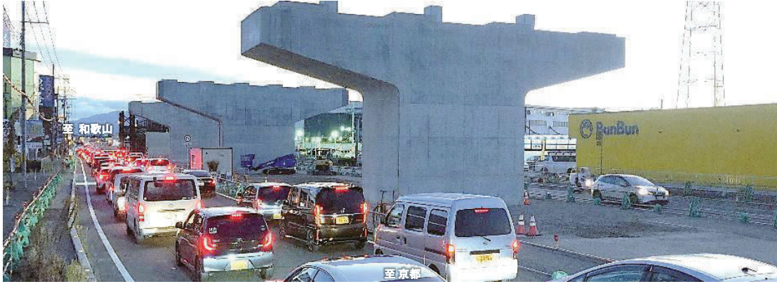
橋梁下部工事等を推進(大和郡山市横田町)
