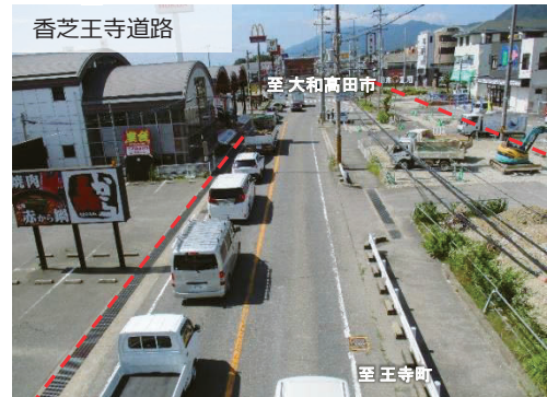
4車線拡幅工事を推進(香芝市上中)
