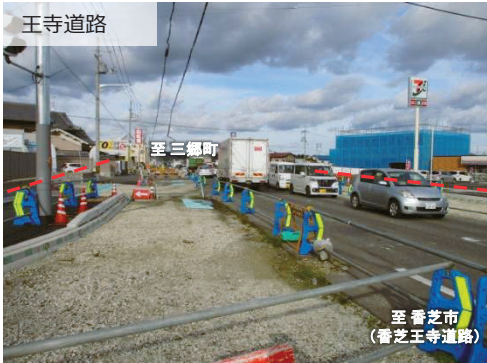
4車線拡幅工事を推進(王寺町畠田)
