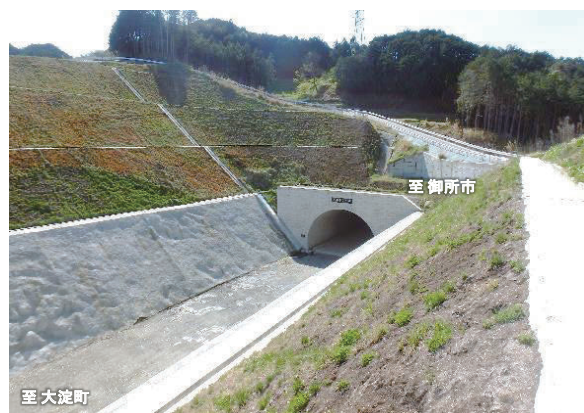
高取トンネル[H31年1月完成](高取町清水谷)
