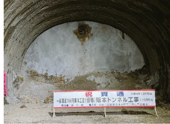
(仮称)阪本トンネル工事を推進(五條市大塔町)
