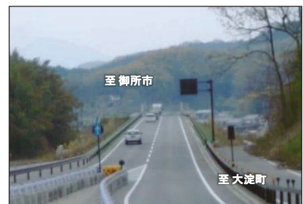
松山高架橋(高取町松山)
