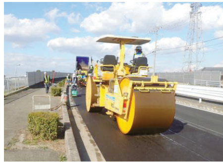
舗装補修工事の状況
