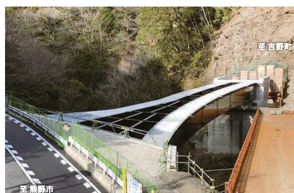
2号橋上部工事を推進(上北山村西原)
