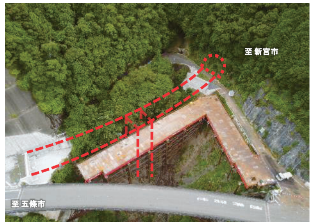
1号橋下部工事を推進(十津川村川津)
