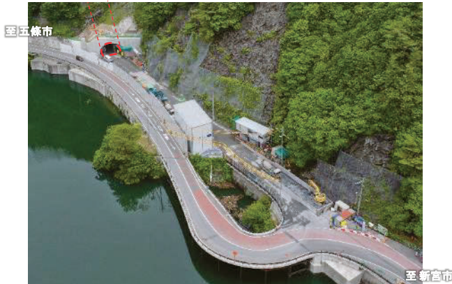
(仮称)阪本トンネル工事を推進(五條市大塔町)
