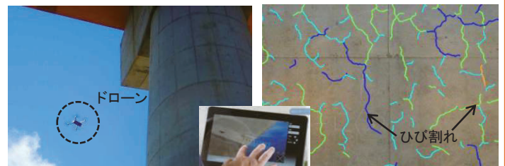
ドローンによる点検、AIを用いたひび割れ診断
