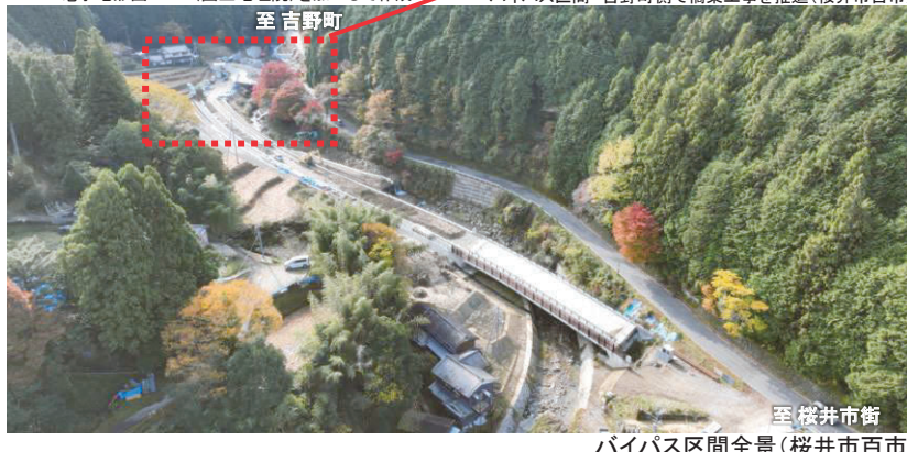
バイパス区間全景(桜井市百市)
