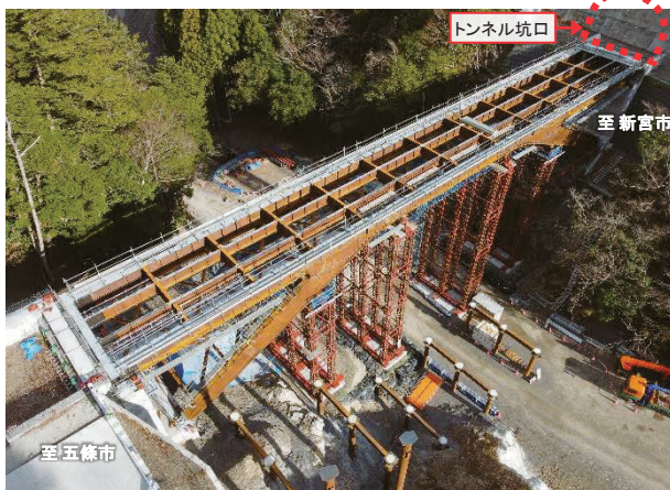
2号橋上部工事を推進(十津川村長殿)
