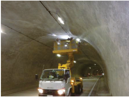
トンネル定期点検の状況
