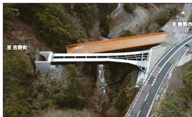
2号橋上部工事を推進(上北山村西原)
