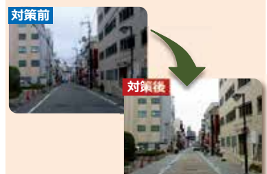
▲無電柱化 (県道大和八木停車場線)
