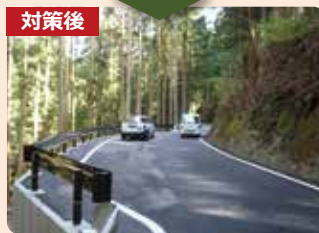
▲ 役場へのアクセス道路の整備 (主要地方道高野天川線 上工区 (野迫川村上地内)(R4.4供用))
