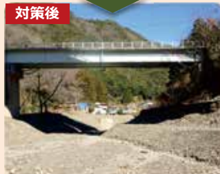
▲ 橋梁の補修工事 (国道168号河津橋)
