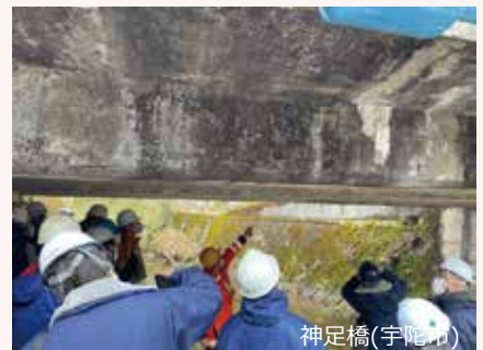
▲県が研修を開催し、市町村職員が専門家から目視検査の着眼点の説明を受けているようす 神足橋(宇陀市)
