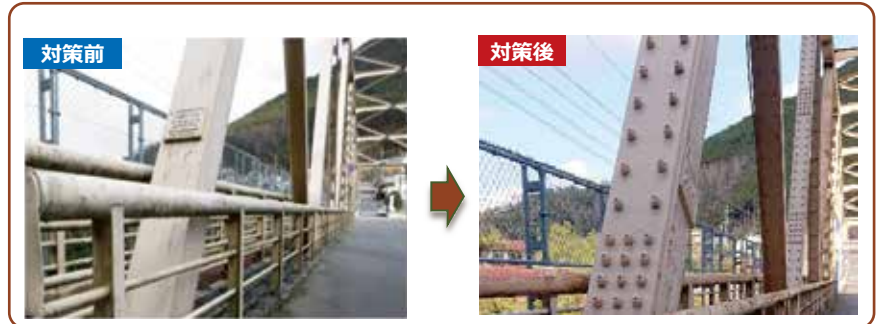
▲当て板補強による補修工事
