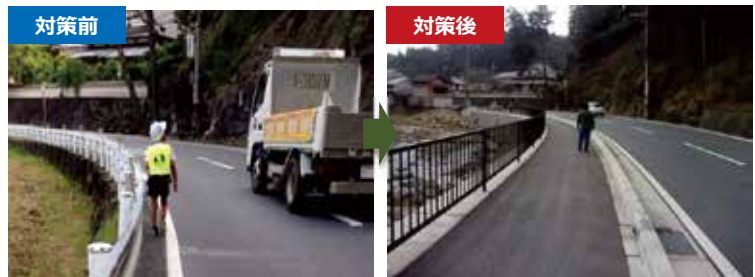
▲歩道設置（国道369号 宇陀市榛原檜牧）
