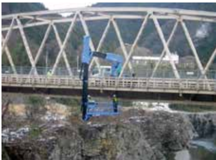
▲定期点検のようす
