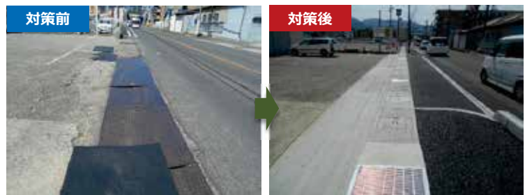
▲歩道設置（国道166号 葛城市尺土）
