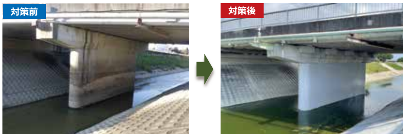
▲橋脚巻立て工による耐震補強工事（田原本広陵線 馬見橋）
