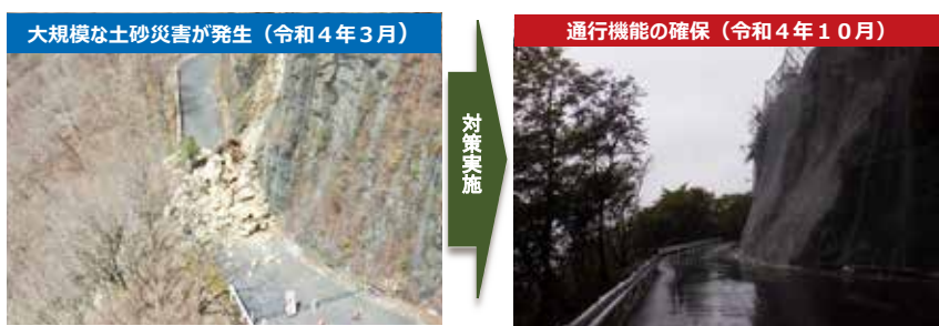
▲法面对策による通行機能の確保（国道309号 天川村北角）
