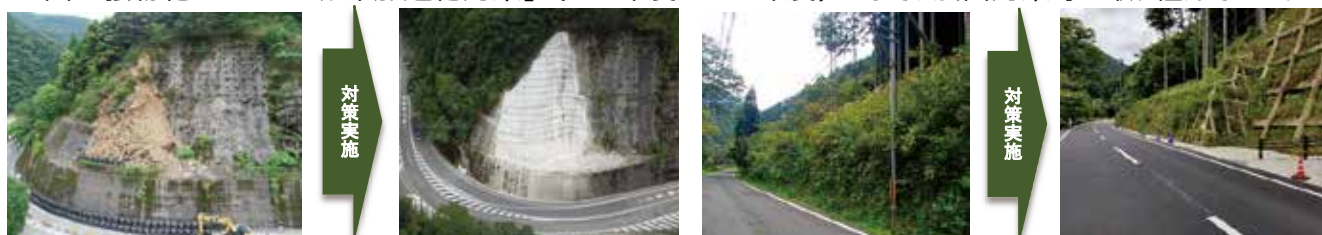
▲法面对策（国道168号 十津川村野尻）
