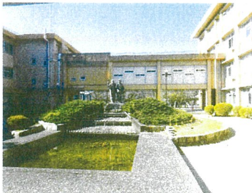
管理教室棟から渡り廊下をみる
