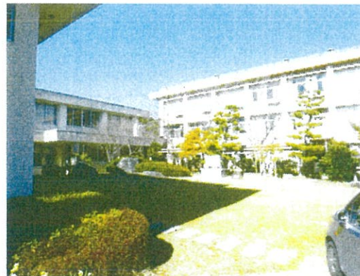
グラウンド側から普通特別教室棟をみる
