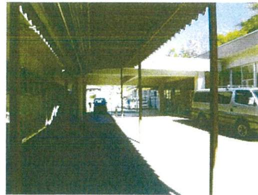
格技場と屋内運動場間の通路
