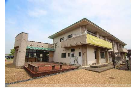
奥大和地域各拠点のHUB 奥大和移住定住交流センター「engawa」
