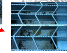
テキサスゲート シカ・イノシシの蹄が間隙に挟まるため、圃場への侵入を防止
