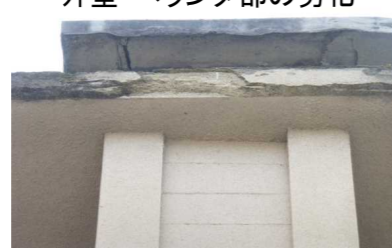
外壁軒先部分のコンクリート片の落下
