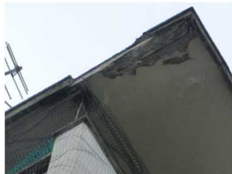
外壁軒先部分のコンクリート片の落下
