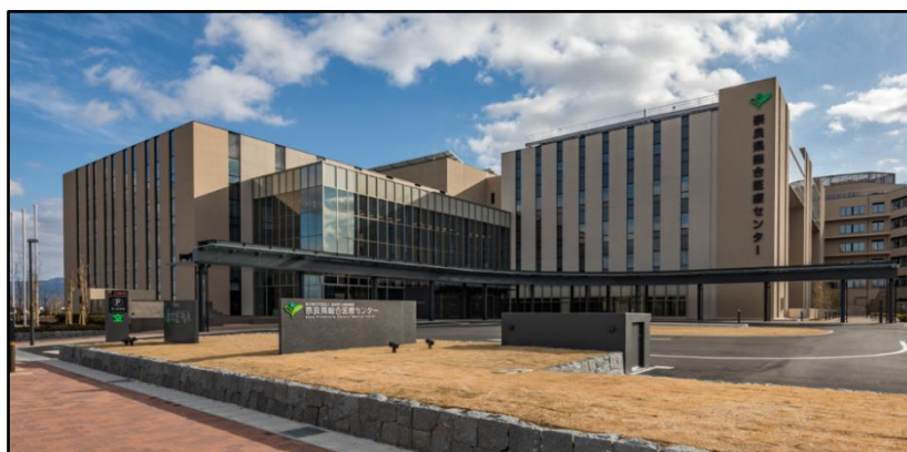
奈良県総合医療センター
