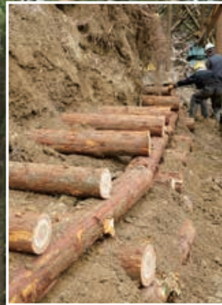
△太い丸太が斜面の土砂崩れを防ぐ。打ち込む釘は太さ長さも特注サイズ
