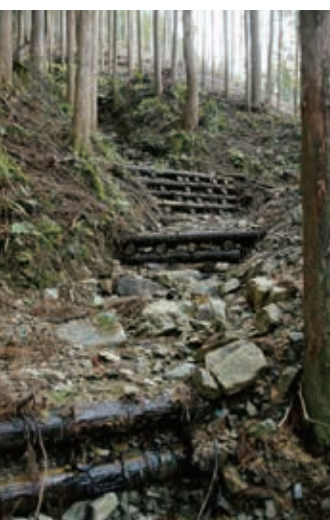
▲丸太の壁で水の流れを変えるなどして、よりよい場所に道を設置するそう
