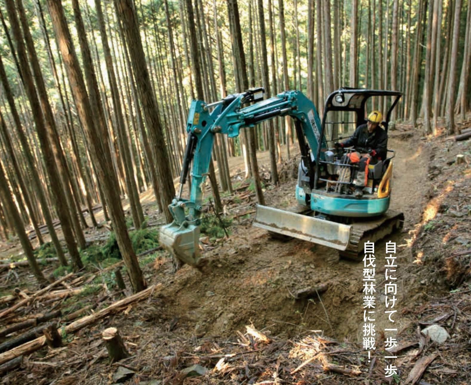
▲道を付ける場所を掘り返し、補強して埋める作業
