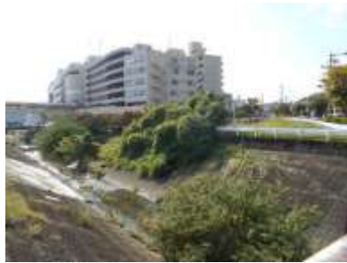
河川内の雑木による景観阻害 (奈良市・秋篠川)
