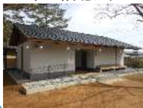
建替後の 五十二段北トイレ
