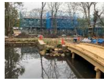
工事中の庭園と飲食施設
