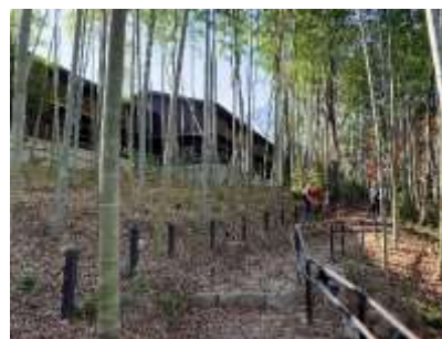
工事中の庭園と宿泊施設
