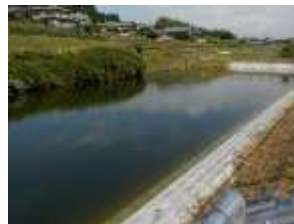
農業用ため池の整備
