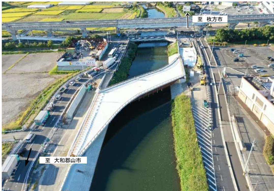
①中町工区南側(R1年度供用箇所)
