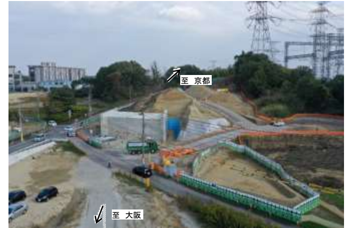
②北田原地区(土工事)
