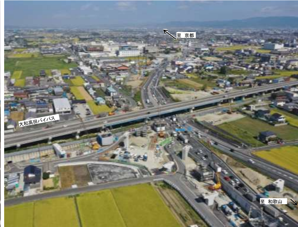
大和御所道路(橿原高田IC付近)
