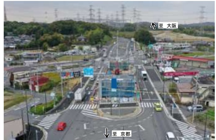
③高山高架橋(橋梁下部工事)
