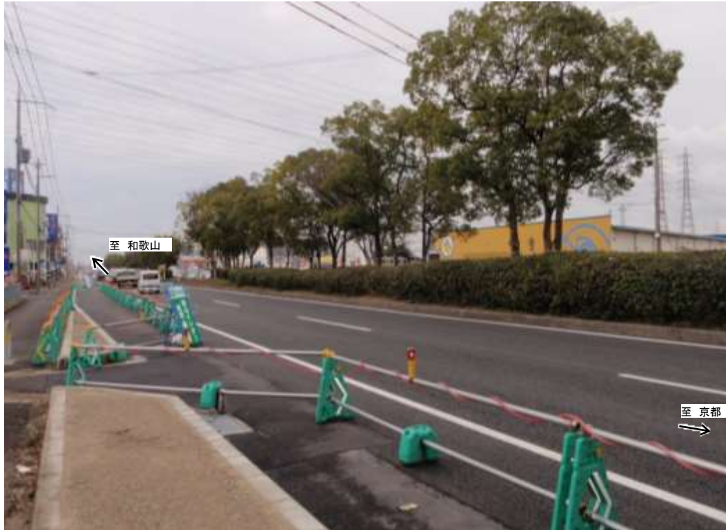
大和北道路(大和郡山市横田町)
