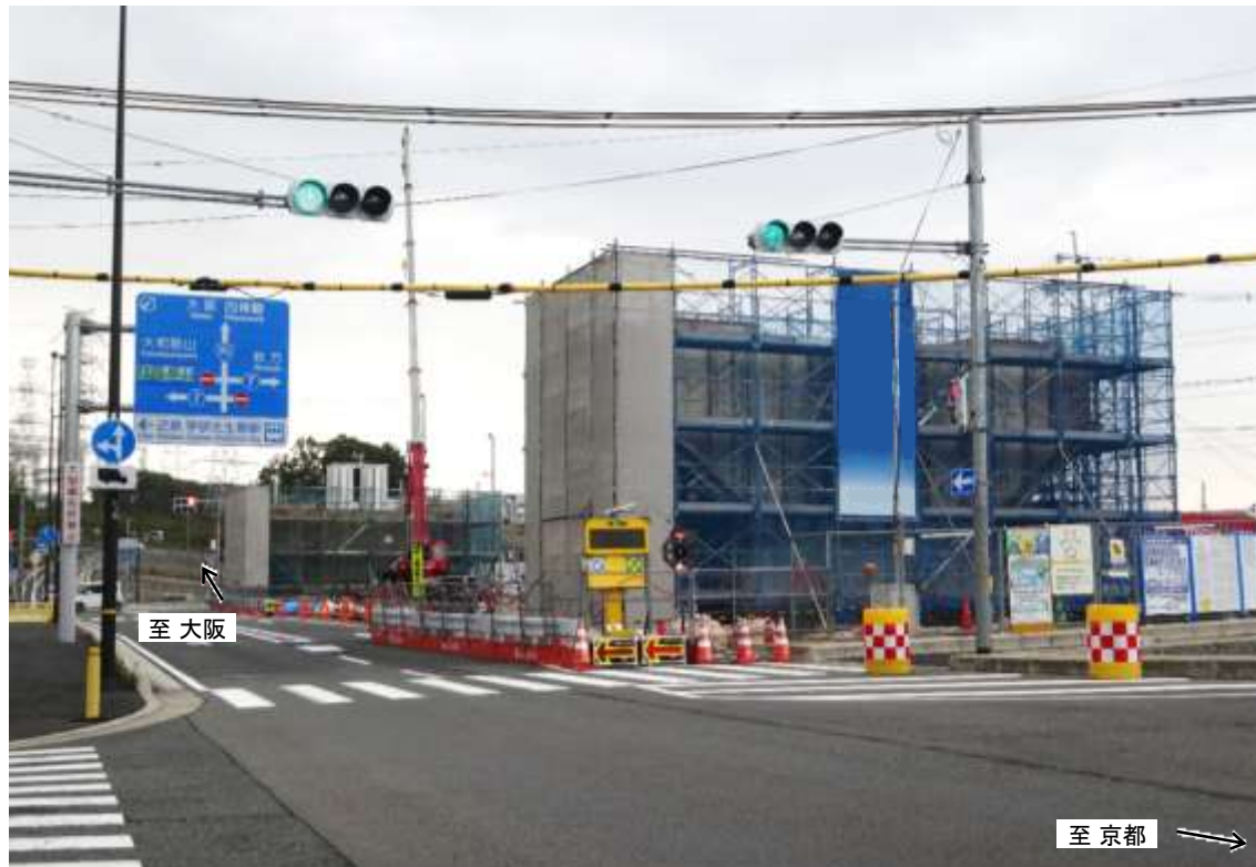
①高山高架橋(橋梁下部工事)
