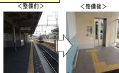
エレベーター設置
