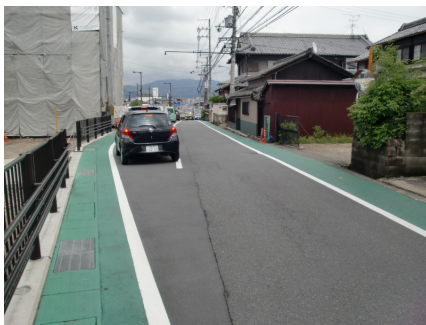
写真-4 路肩のカラー舗装化例(奈良市尼辻中町)
