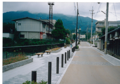
写真-7 歩道にベンチを設置した例 (天理市柳本町)
