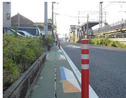
写真-5 側溝の蓋掛け例(大和高田市築山)
