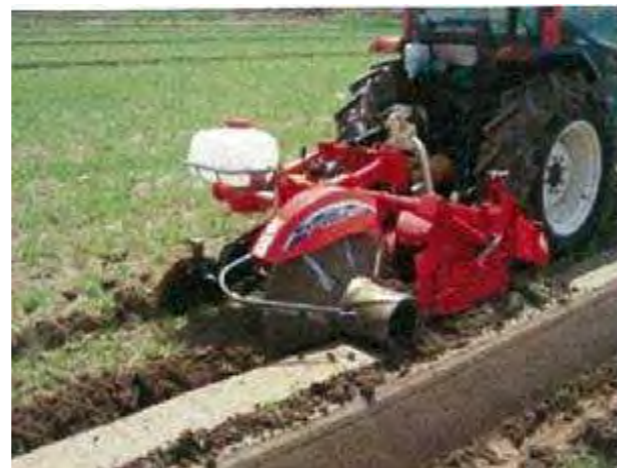
畦畔の補強、かさ上げ
