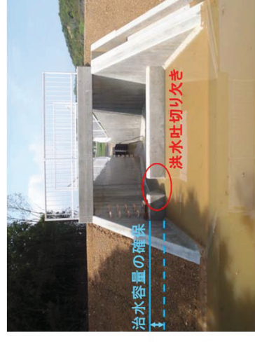
洪水吐切り欠きの設置により治水容量の確保を行った事例
