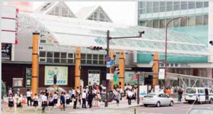
奈良近鉄ビルから商店街までを覆う大屋根の全景
