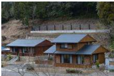
<十津川村復興住宅>
