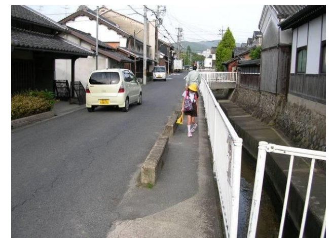
歩道状況 (歩道幅員は0.8m程度しかなく、歩行者のすれ違いはできない。雨の日は雨具が車道へはみ出し非常に危険。)
