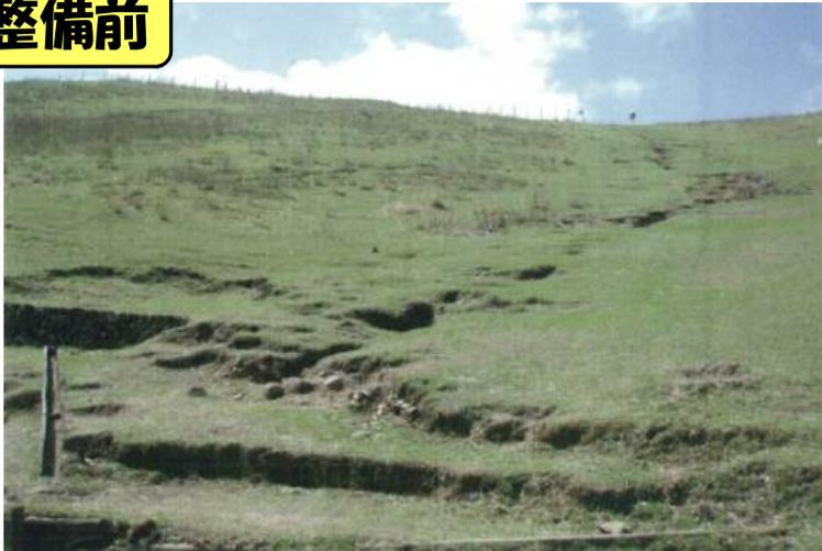
雨水による斜面の浸食状況(平成22年)
