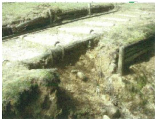
斜面の崩壊、土砂の流出状況(平成22年)
