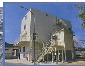
▲活性炭注入施設
