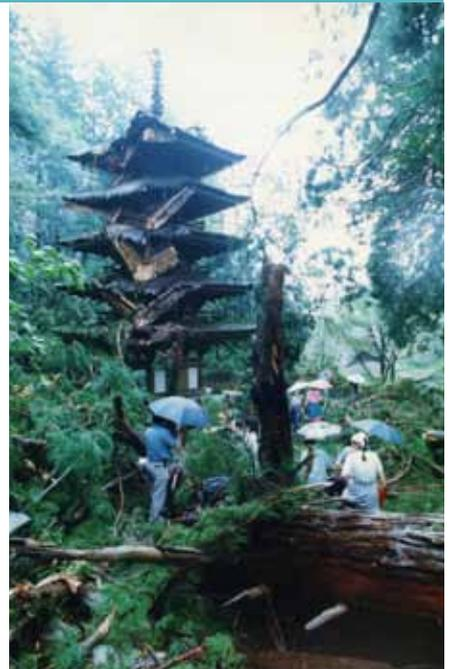
▲倒木で大きく破損した室生寺五重塔
