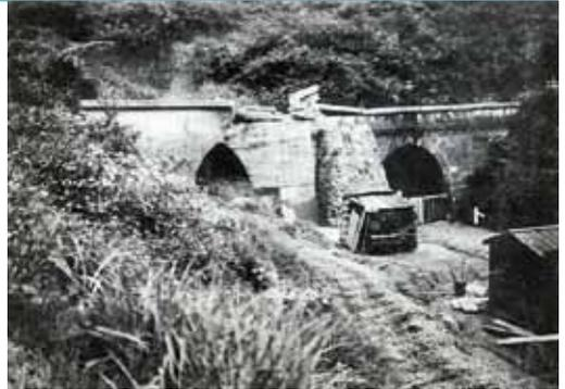
▲地滑りの影響で崩落した亀の瀬トンネル
