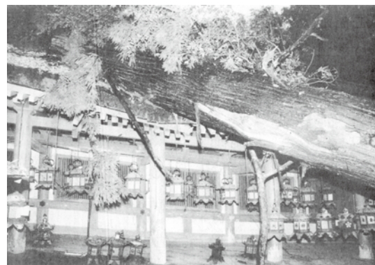
大杉が倒れ、破損した春日大社東廻廊 （『奈良新聞』平成10年9月24日付より）
