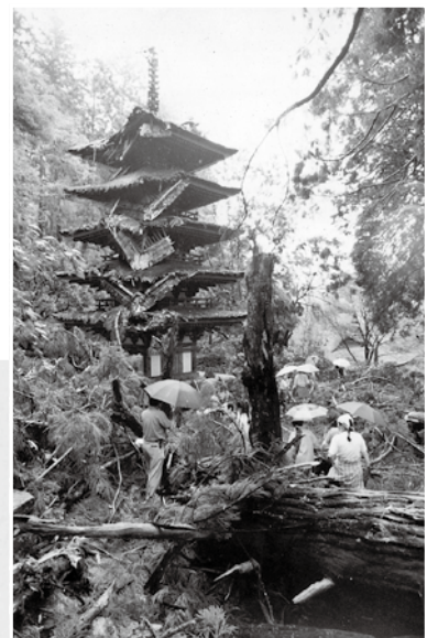
倒木で破損した室生寺五重塔
