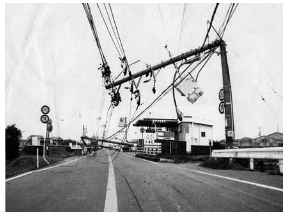
強烈な西の風で北東側に倒れたコンクリート電柱 （香芝市鎌田）（写真提供：奈良新聞社）
