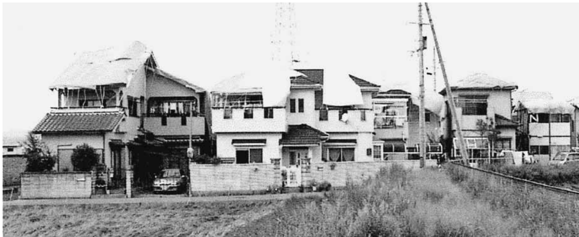
瓦などがはがれ、1週間経過してもビニールシートで覆われた屋根 (写真提供：奈良新聞社)
