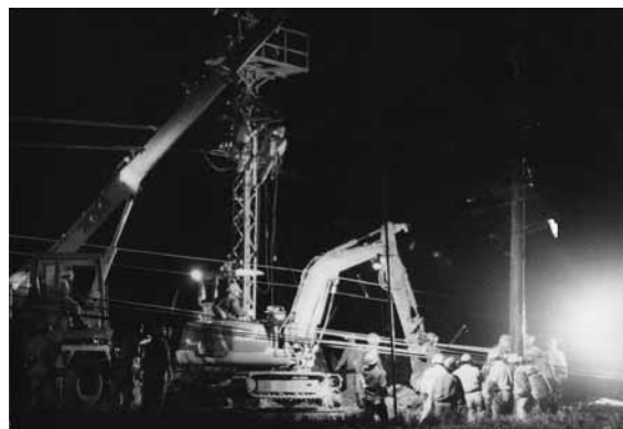
夜間の鉄道復旧作業 (写真提供：奈良新聞社)
