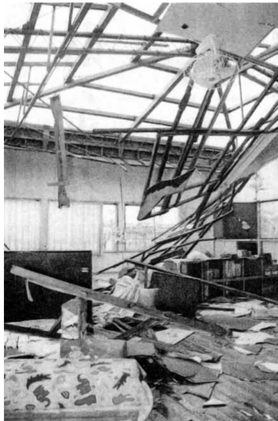
屋根が吹き飛ばされた保育所 (「奈良新聞」平成10年9月25日付より)
