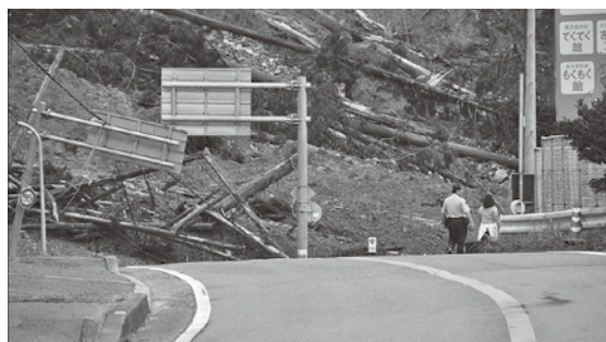
大規模崩壊により国道169号が寸断された迫地区 (『村史最大の惨禍 語りつぐ伊勢湾台風』より)
