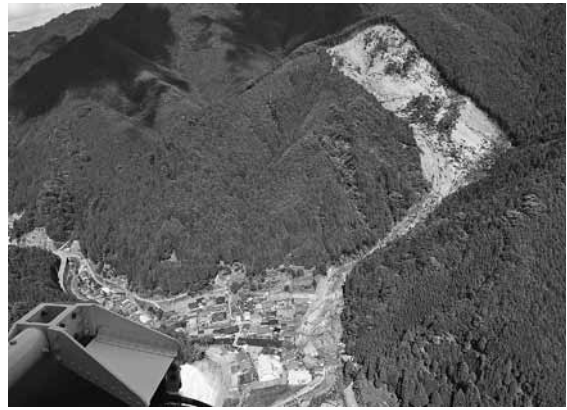
北股の集落の近くで発生した深層崩壊 〔『紀伊半島大水害の記録』より〕
