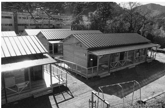
十津川村平谷の応急仮設住宅 （『紀伊半島大水害の記録』より）
