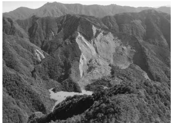
最大の崩壊地となった栗平と河道閉塞 （『紀伊半島大水害の記録』より）
