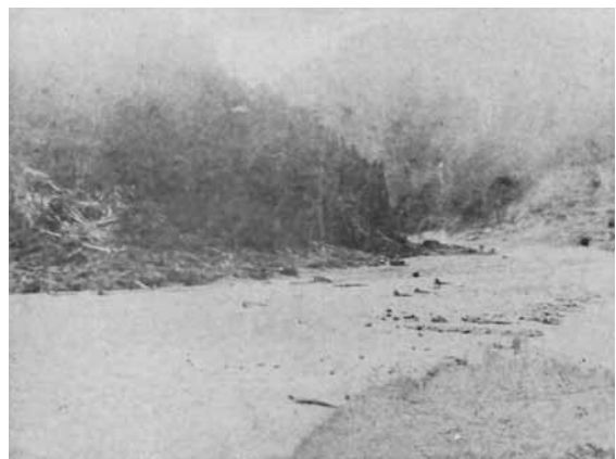
大塔村大字宇井（現五條市大塔町）も、洪水で全ての民家が流された（『吉野郡水災誌』より）
