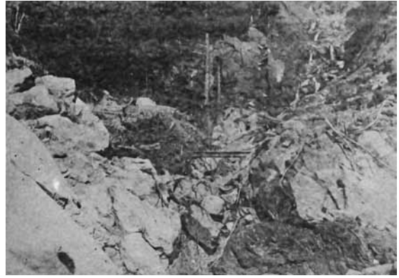
北十津川村高津領中山の大規模崩壊地 （『吉野郡水災誌』より）
