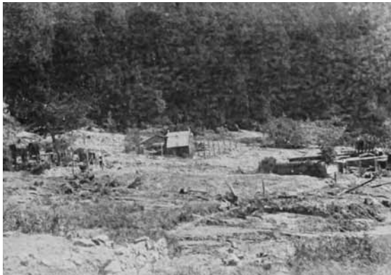
北十津川村大字上野地の集落はほとんど流された （『吉野郡水災誌』より）
