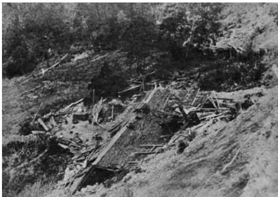
中十津川村小森。山崩れで崩壊した民家 （『吉野郡水災誌』より）
