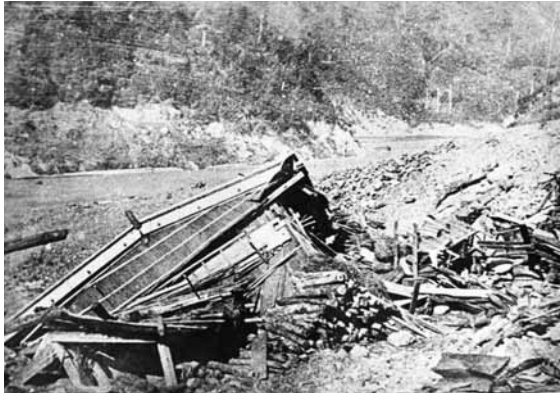
北十津川村大字長殿で洪水のため流失した家屋 （『吉野郡水災誌』より）
