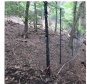
植生保護 柵の設置 状況
