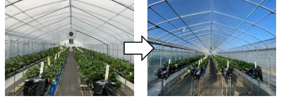
内張閉めきり
