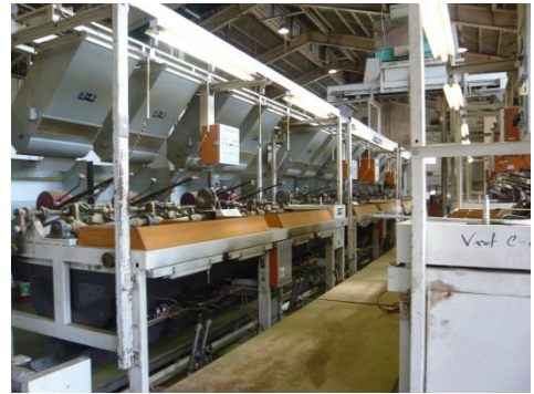
機械化された大型自動製茶工場
