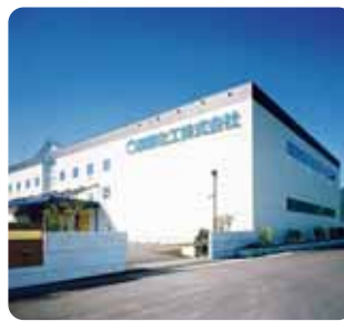
本社工場第一工場棟外観
