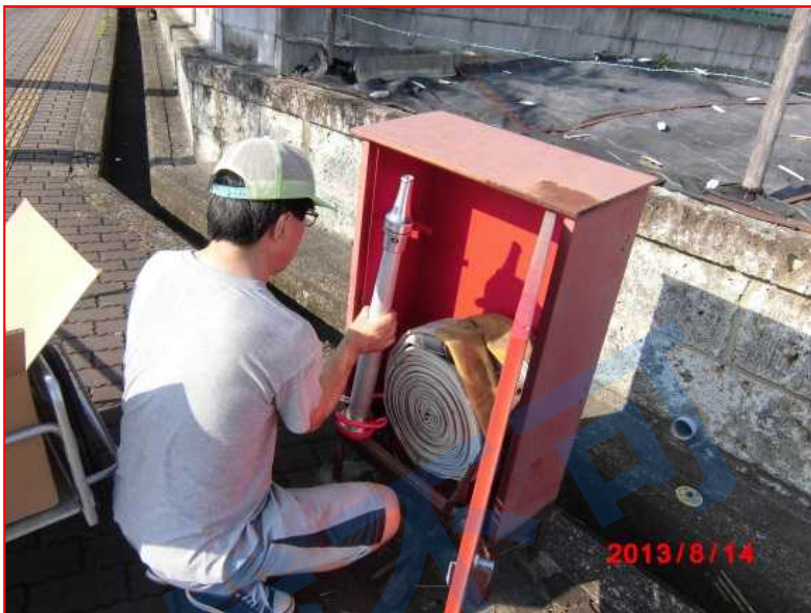
写真 15 消火器具の補充 (25年8月)
