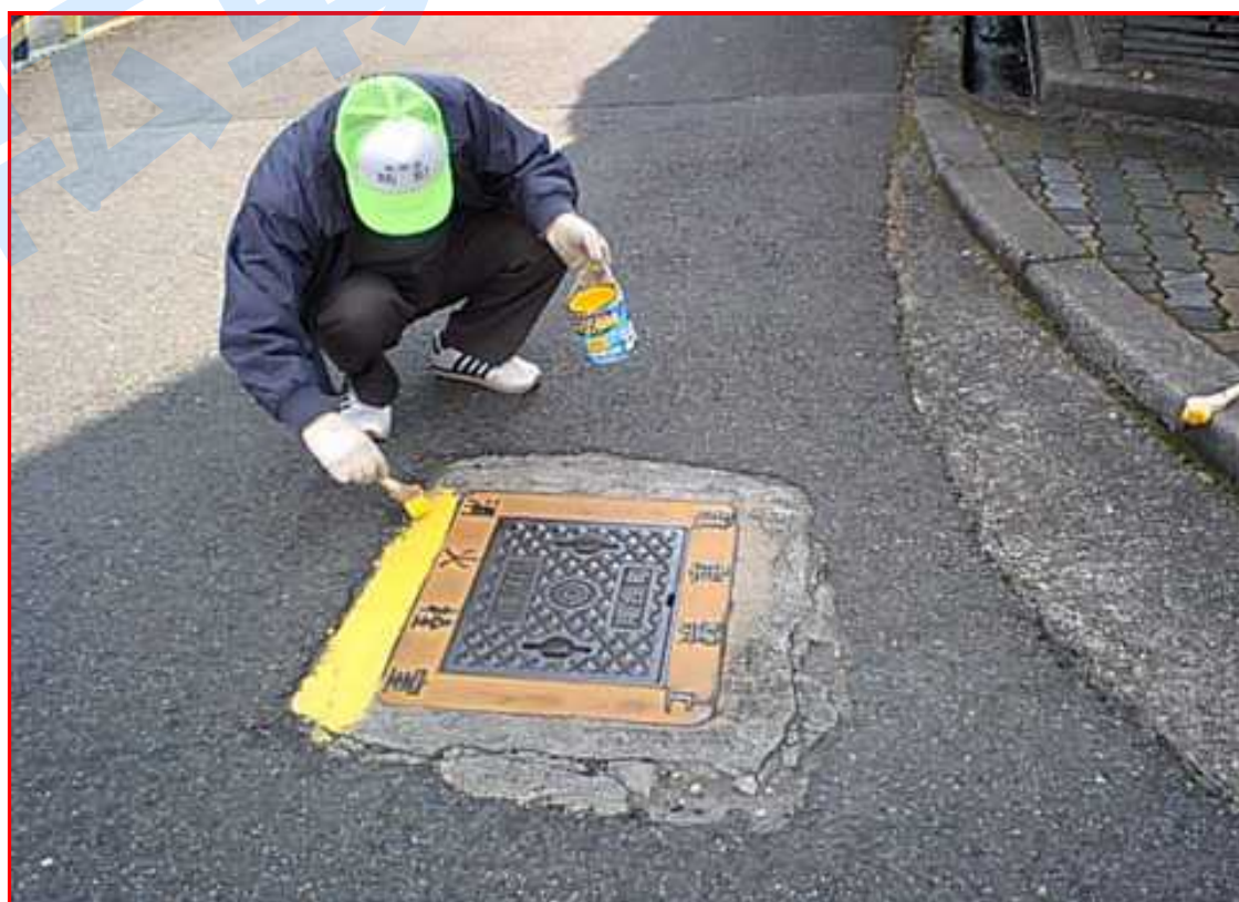
写真8 消火栓周囲の塗装（24年2月）
