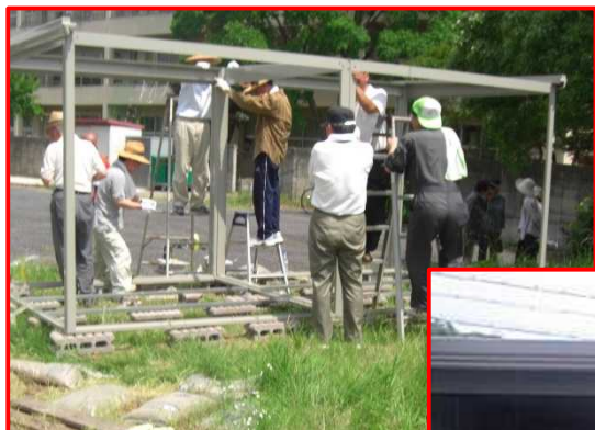
写真9 2丁目防災倉庫組立完了（24年7月）
