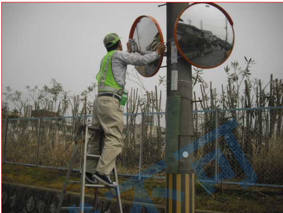
写真 13 カーブミラー清掃と点検 (25年3月)
